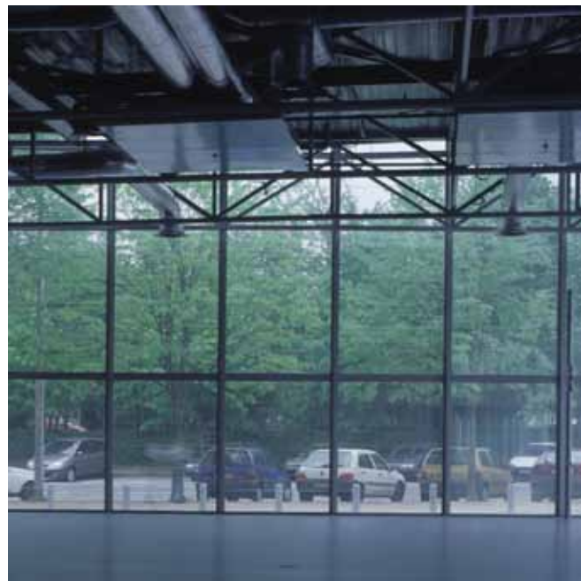
the «peristyle», Media Library, Vénissieux, France
